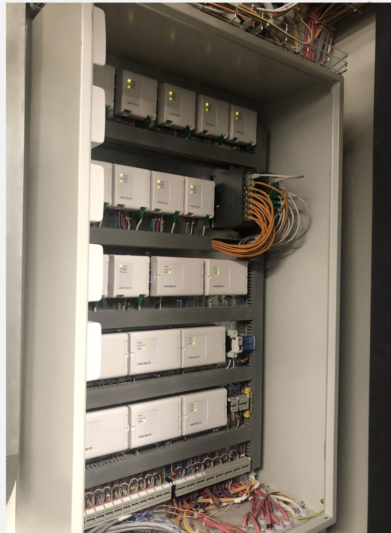
**Система выдает** управляющие сигналы на отключение систем вентиляции и кондиционирования, на включение системы противодымной защиты, а также систем оповещения.
