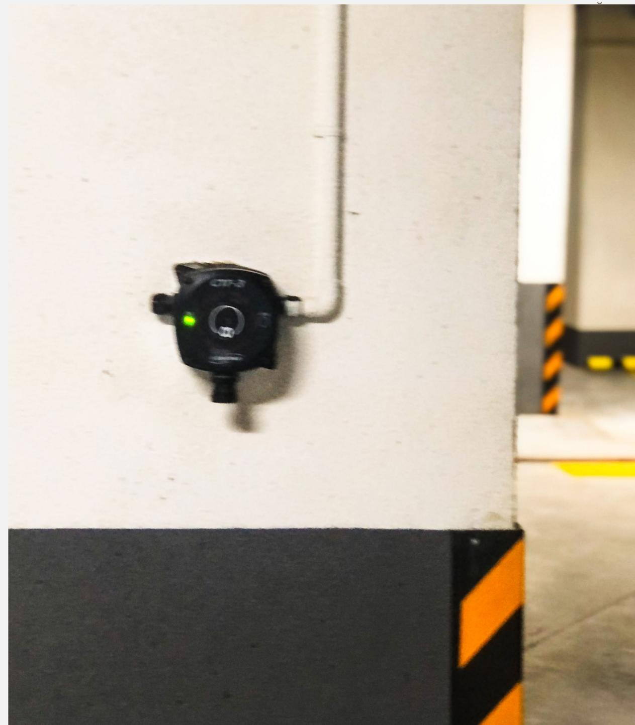
сопровождается световой индикацией в автопарковке в зоне сработки датчика.
